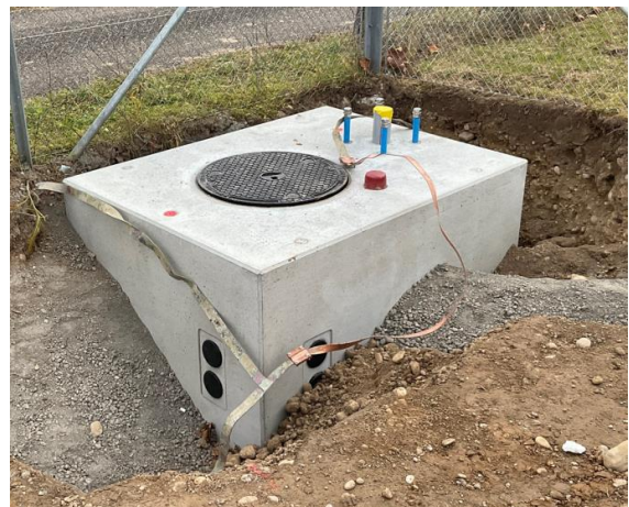
Abbildung 13: Kabelzugschacht
